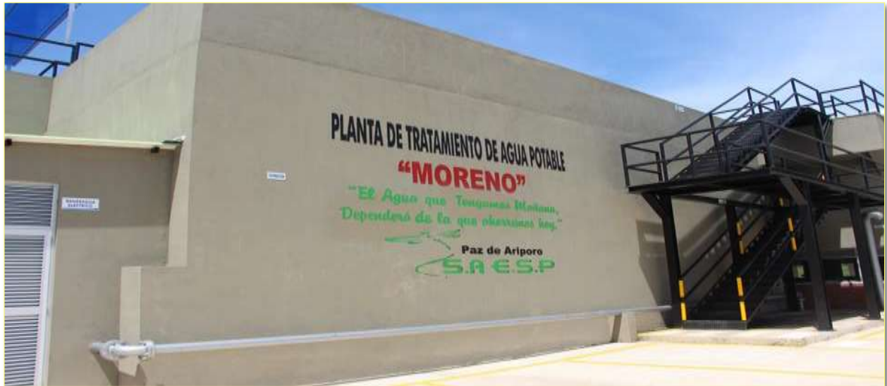
Fuente. Área de acueducto y alcantarillado, 2018
