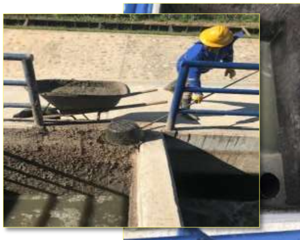
Limpieza periódica de la Trampa de grasas
