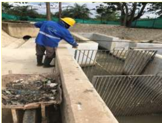
Mantenimiento al sistema de Cribado (rejas manuales y automáticas).
