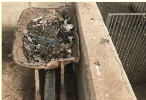
Mantenimiento al sistema de Cribado (rejas manuales y automáticas).
